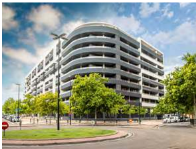
Basa de la Mora, promoción de viviendas inteligentes con certificado Passivhaus
