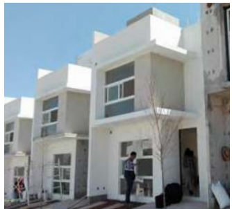
Primera casa que cumple el estándar internacional Passivhaus en México
