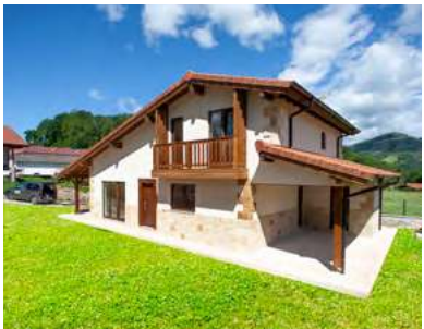
Unifamiliar con estructura de madera de entramado ligero en Irurita (Navarra)
