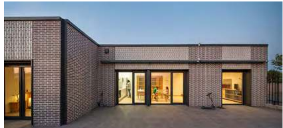
Primer unifamiliar certificado Passivhaus en La Rioja
