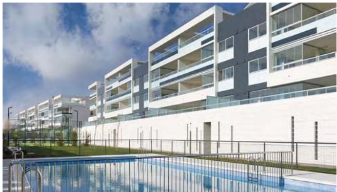
Residencial Scenia, certificado Passivhaus con monoblock de altas prestaciones
